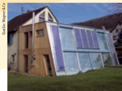
Quelle: Wagner & Co Solarkollektoren lassen sich auch harmonisch in die Fassade integrieren
