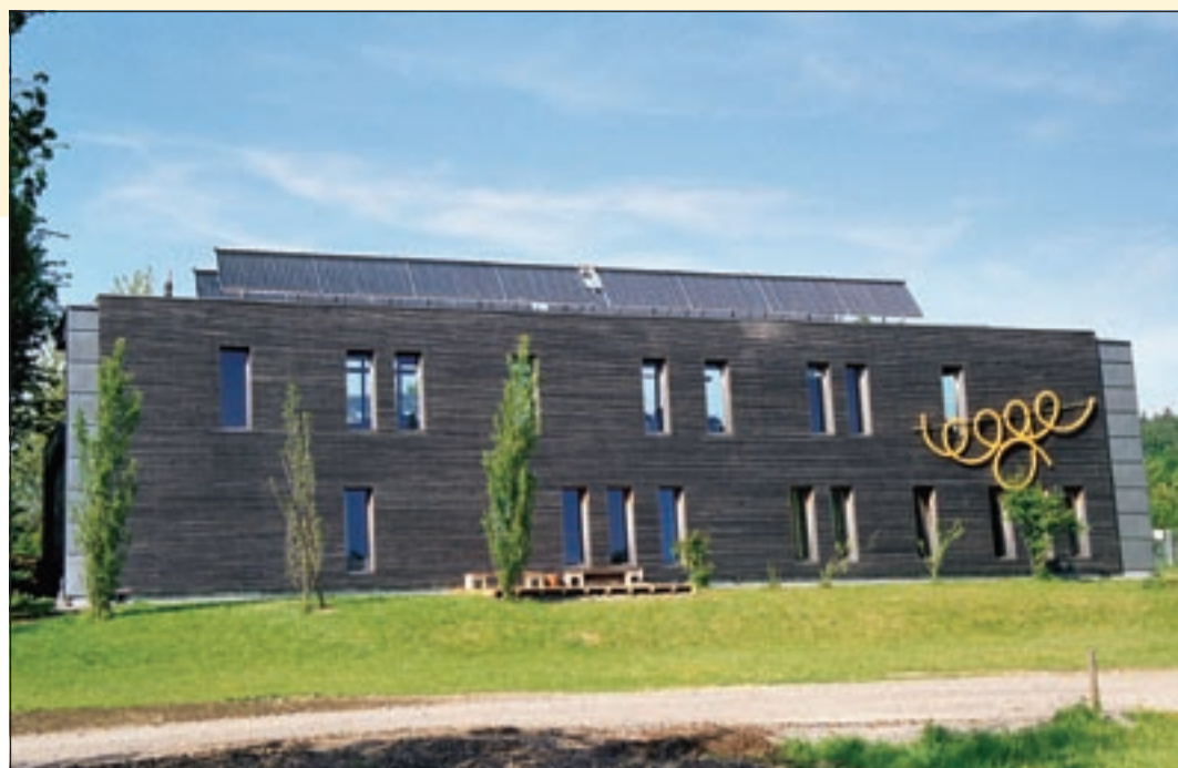
Quelle: Paradigma Solarwärmeanlagen lassen sich problemlos in die Architektur von Gebäuden einpassen
