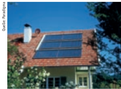
Quelle: Paradigma Am einfachsten werden Solarkollektoren über der Dachhaut montiert – speziell bei Nachrüstungen und gutem Zustand des Dachs.
