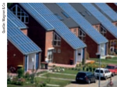
Quelle: Wagner & Co Zur maximalen Solarenergienutzung kommen vollflächige Solardächer – wie hier in Hamburg Brahmfeld – zum Einsatz.
