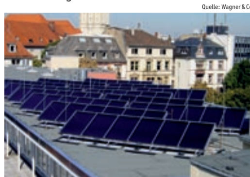
Quelle: Wagner & Co Auf Flachdächern können selbst in dicht bebauten Innenstädten große Solaranlagen errichtet werden
