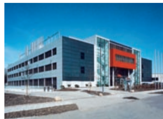
Quelle: Grammer Solar 240 m 2 Solar-Luft-Fassade am Forschungs- und Entwicklungsgebäude von Beiersdorf-Lilly in Hamburg.
